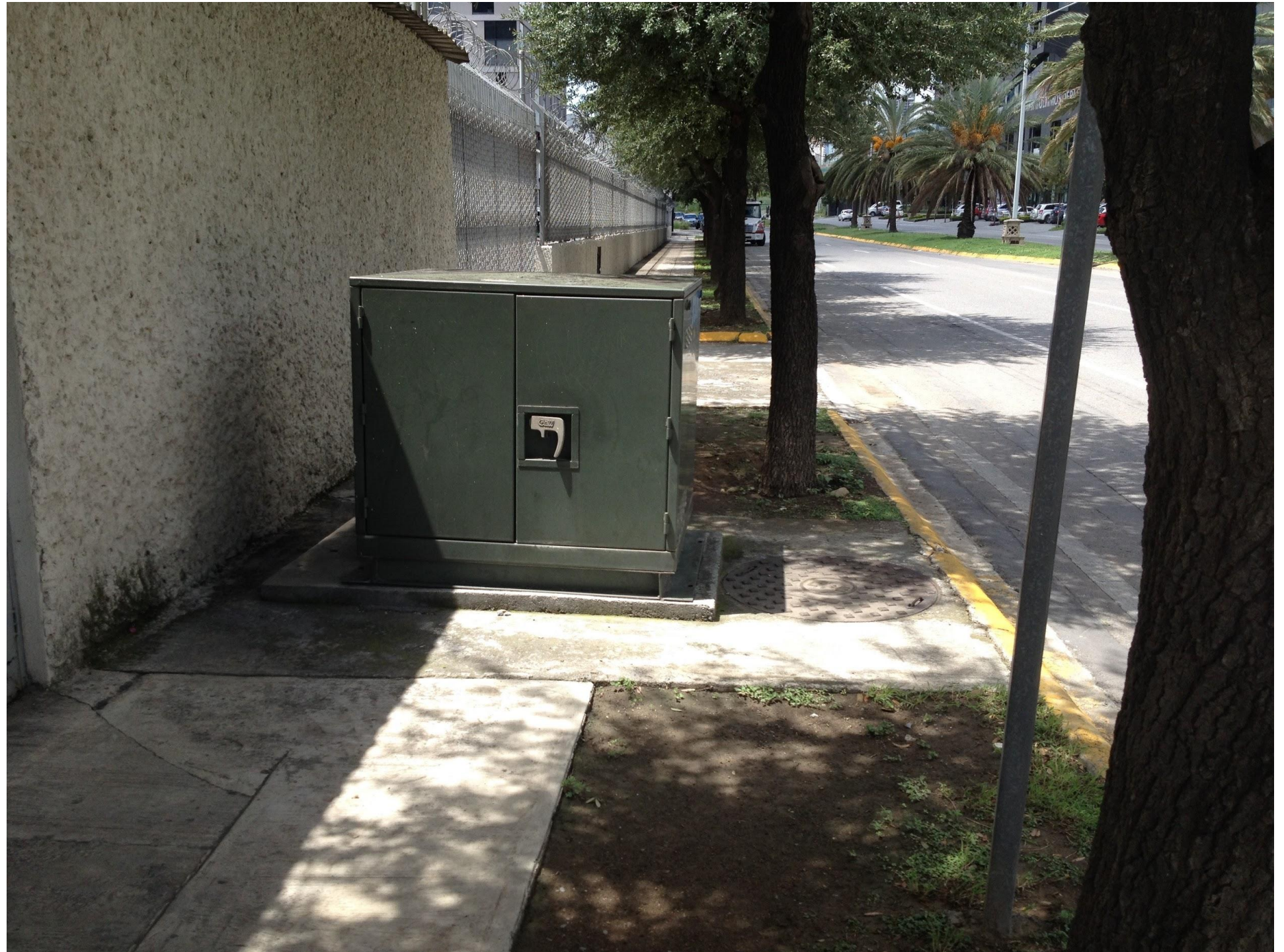
TRANSFORMADOR CFE
