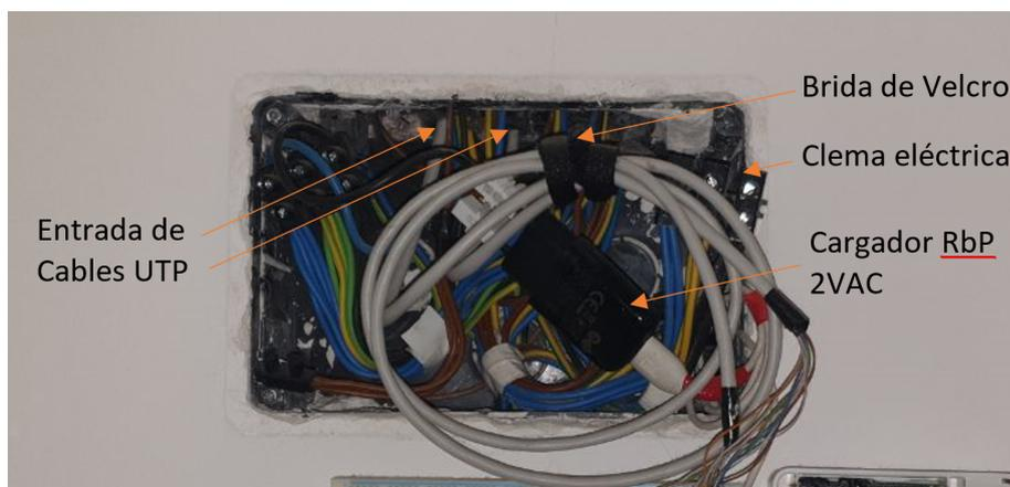
Figura E.3: Caja de derivación principal instalada.
