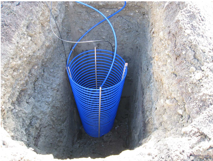
FIGURE 1.7 – Mise en œuvre à la pelle mécanique (INES, Savoie-Technolac)
