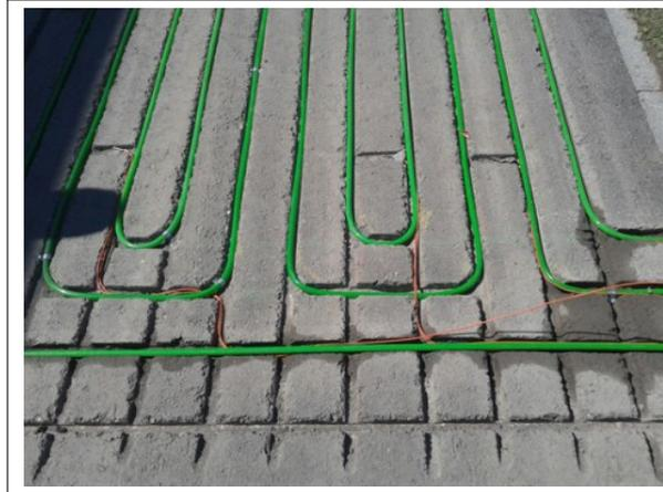
FIGURE II.6: Les serpents de captage de l'énergie solaire [8]
