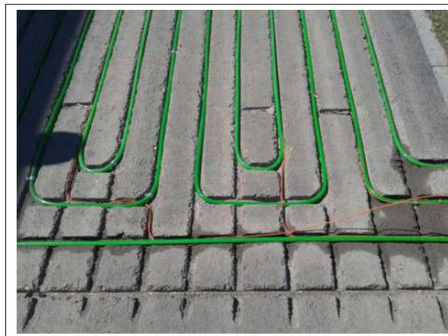
FIGURE II.6: Les serpentins de captage de l'énergie solaire [8]
