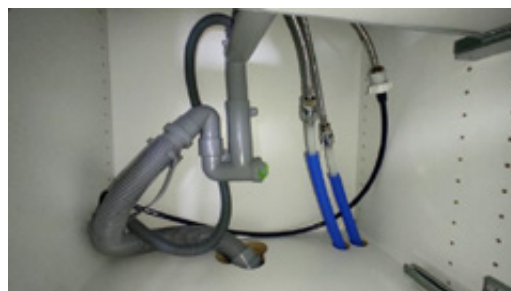
Kontroll av røropplegg.
