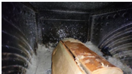
Kontroll av ildsted.
