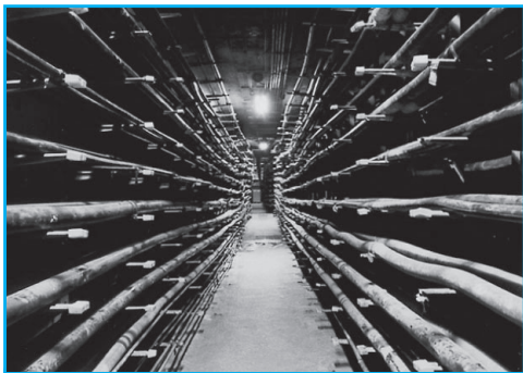
照片 4.1 电缆隧道
